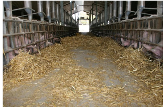
Abb. 7: Mit Traktor befahrbarer 2.30 m breiter Futtergang
