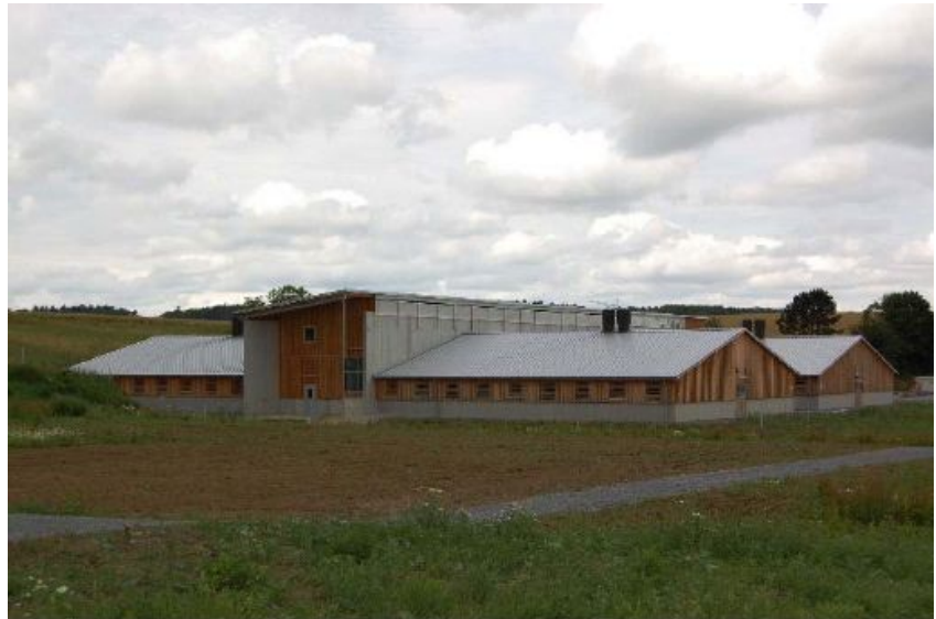
Bild 1: Die neuen Mastställe der LSZ Boxberg
