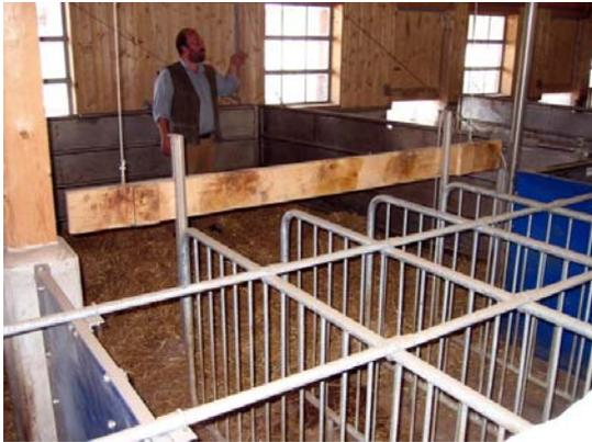
Abb. 1: Einfacher Brettverschluss an Elektro-Seilwinde.
