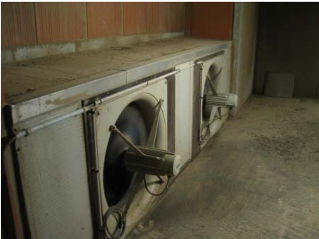
Abbildung 1: zentrale Unterflurabsaugung
