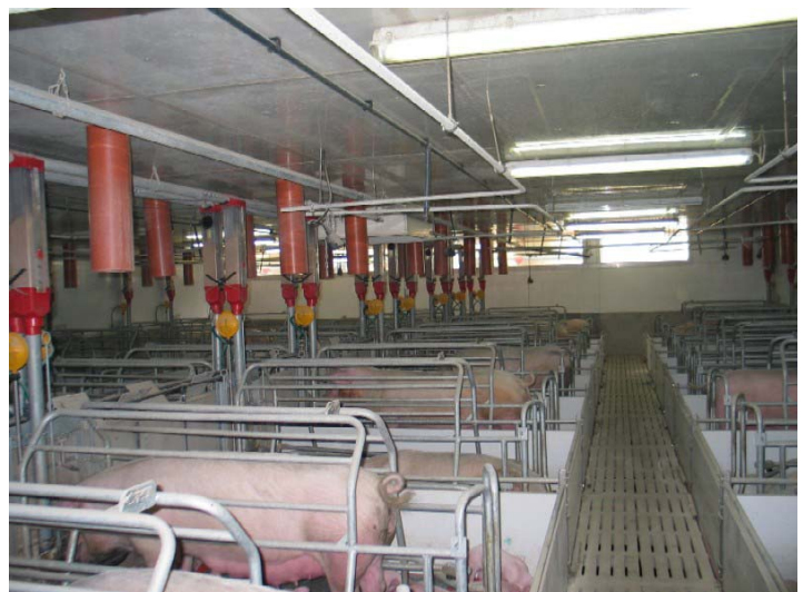
Abbildung 2: Blick in ein Abteil mit Nasenlüftung von oben
