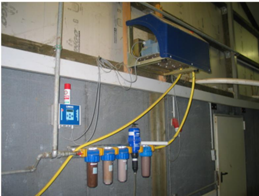
Abbildung 5/6: (links) Hochdruckbefeuchtungsanlage mit dazu gehörenden Filteranlagen; (rechts) Vernebelung des Wassers im Abteil
