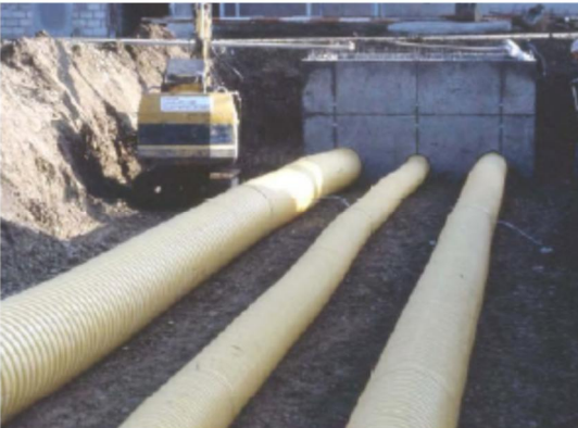
Abbildung 9/10: (links) Einbau eines Rippenrohrtauschers; (rechts) Schutzgitter + Abdeckung um die Zuluftrippenrohre gegen Eintritt von Schmutz
