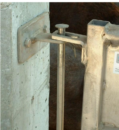
Abb. 4: Damit das Schwenktor beim Schließen „bergauf“ gehen kann, bewegt sich der Eisenstab in einem Langloch.
