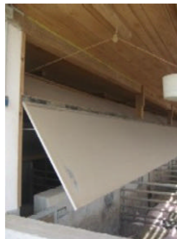
Bild 2: Klappdeckel mit Seilantrieb
