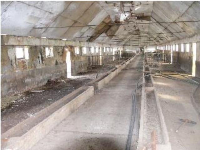
Abb. 3: Die Weiternutzung alter bestehender Stallgebäude machte Ersatzinvestitionen in Stalltechnik unumgänglich, da die bestehenden Anlagen in keinsten Weise dem Stand der Technik und tierschutzrechtlichen Ansprüchen entsprachen.
